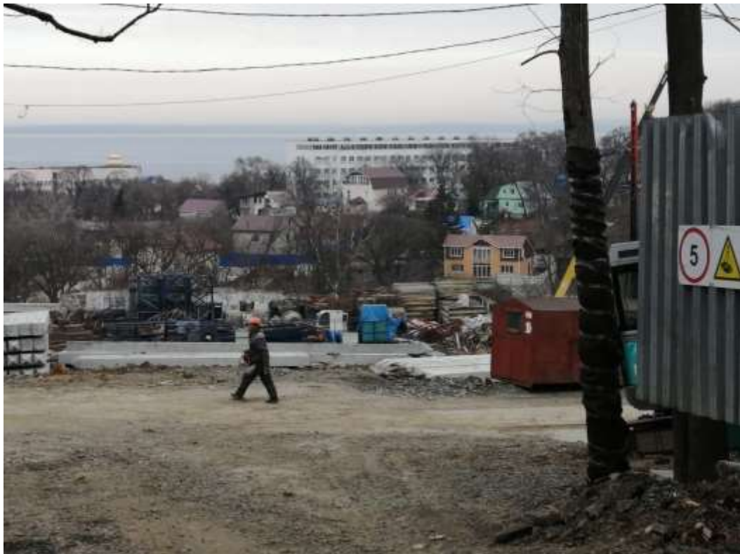
Рис. 11. Строительные работы в бассейне руч. «Академический»
