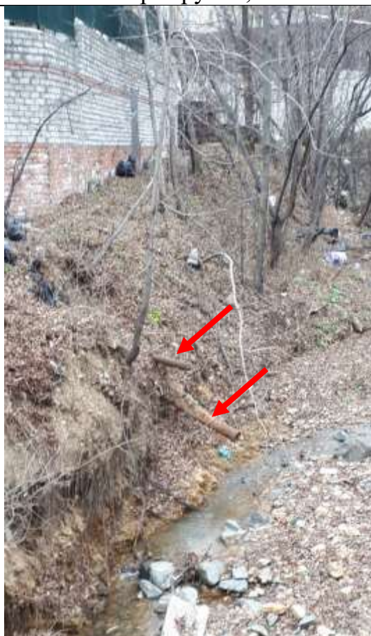
Рис. 7. Выходы канализации. Постройки – в водоохранной зоне
